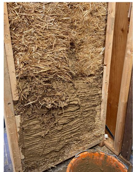
Gefach mit Strohdämmung und teilweise mit Lehmputz
